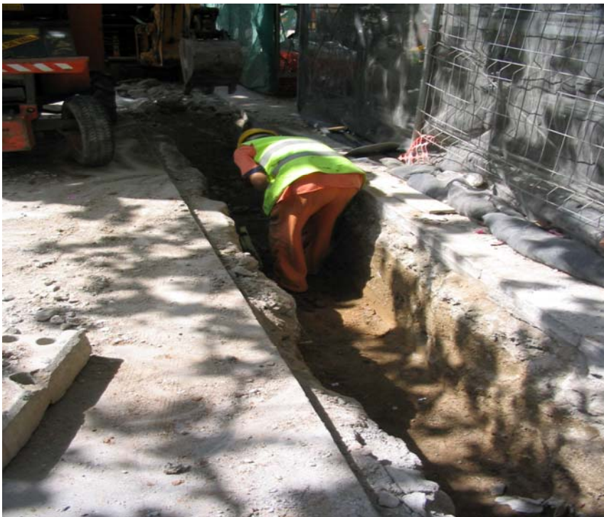
Fotografia núm. 5. Obertura de la rasa 200
