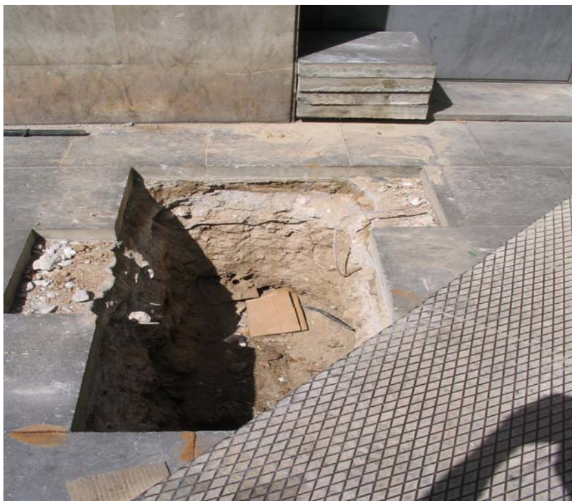
Fotografia núm. 12. Rasa 700 un cop oberta
