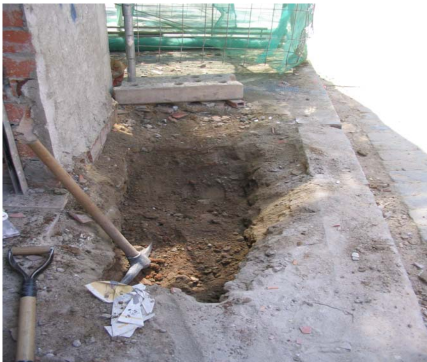
Fotografia núm. 1. Obertura de la rasa 100
