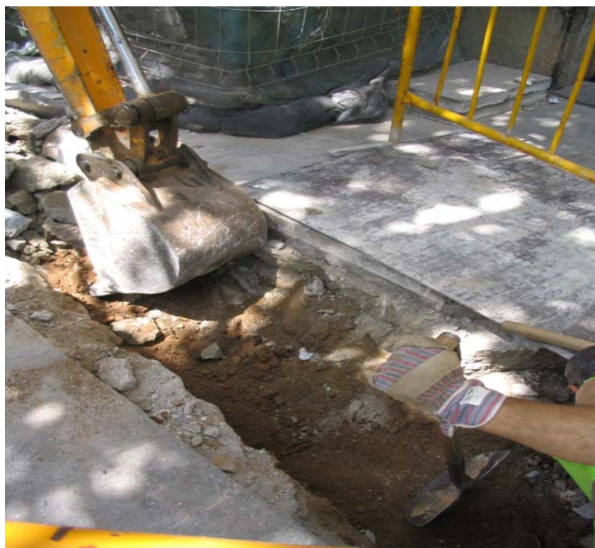
Fotografia núm. 2. Obertura de la rasa 100
