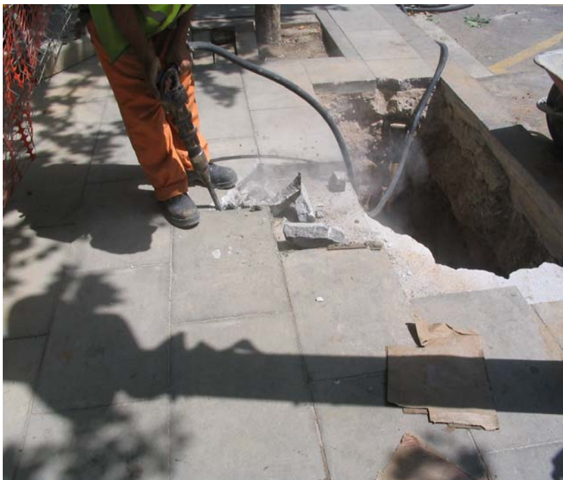
Fotografia núm. 8. Obertura de la rasa 300
