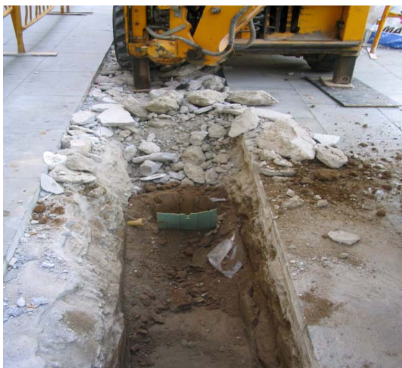
Fotografia núm. 4. Obertura de la rasa 200
