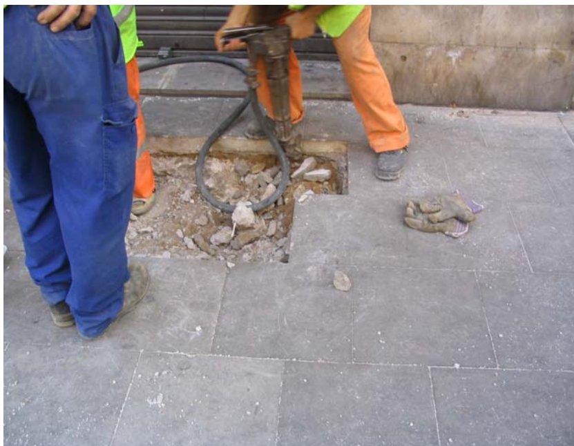
Fotografia núm. 10. Obertura de la rasa 600
