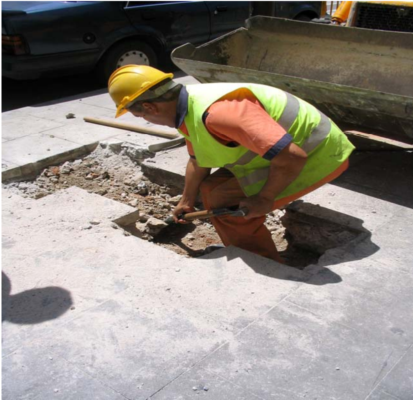
Fotografia núm. 7. Obertura de la rasa 300
